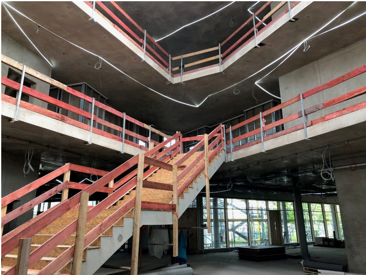
Blick vom Haupteingang auf die Haupttreppe mit Einsicht auf Mensabereich
