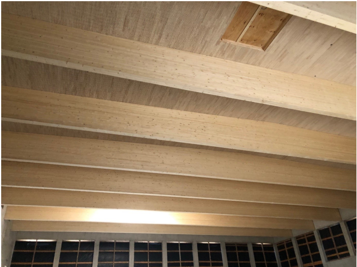
Decke der Turnhalle
