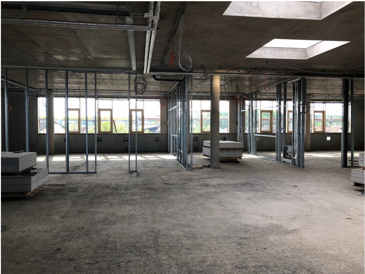
Blick auf die zukünftigen Klassenzimmer
