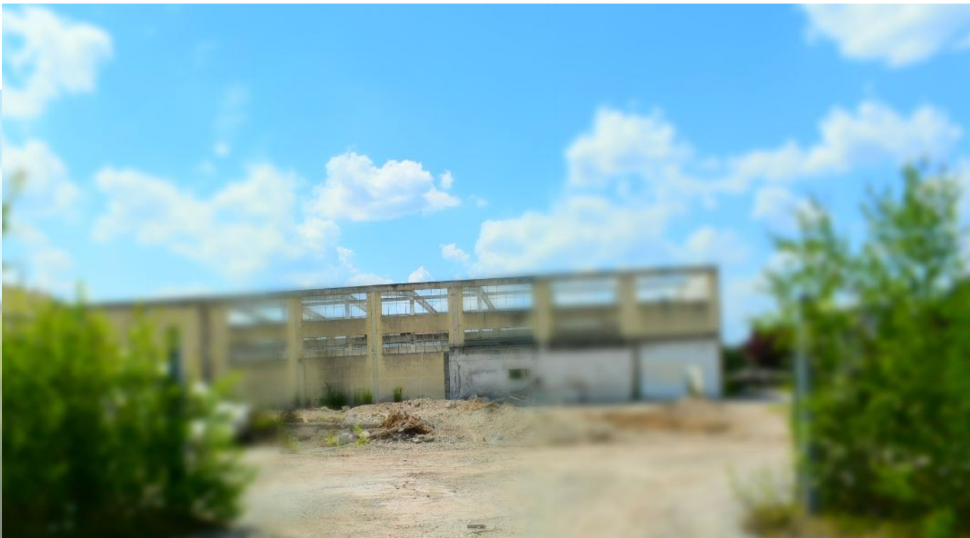
Leuchtturmprojekt der Innenentwicklung: Konversion des ehemaligen Betonwerks Hemmerlein Foto Salm & Stegen 2020
